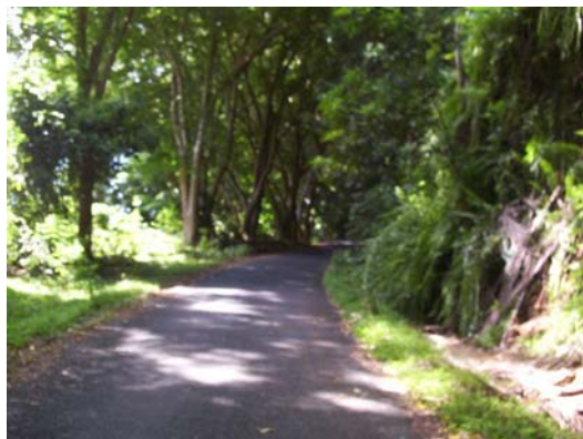
Etat de la route avant déboisement
