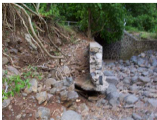
Pont de Hoani
